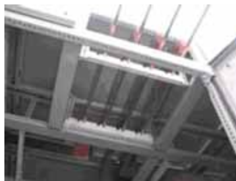
Рис. 13. Шинные выводы
