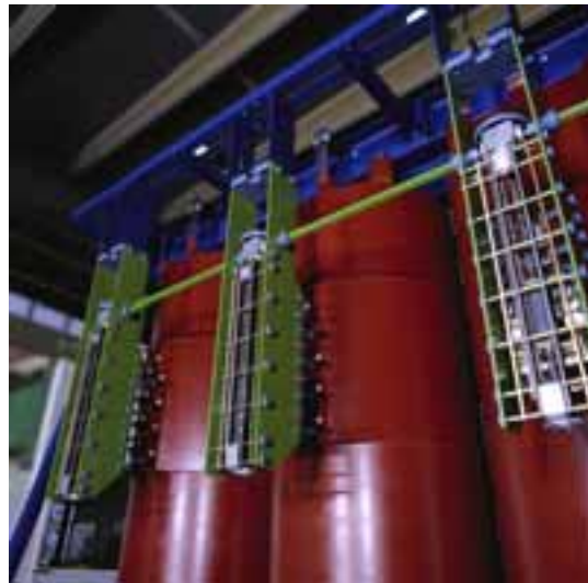
Рис. 9. Смонтированный на трансформатор трёхфазный комплект РПН Vacutar VT
