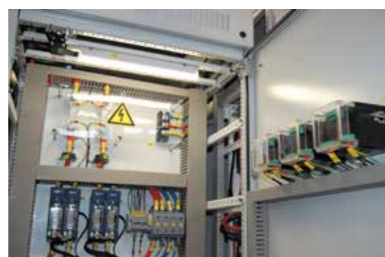
Рис. 3. Защита от прикосновения к токоведущим частям
