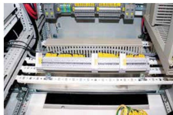
Рис. 2. Пример расположения клеммников для подключения внешних кабелей
