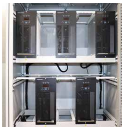
Рис. 9. Транзисторные выпрямительные модули
