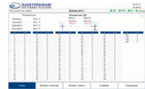
Рис. 14. Экран поэлементного контроля АБ
